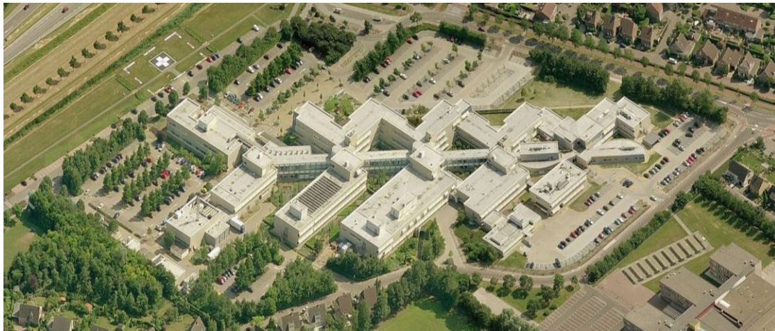
Fig. 3.9 De Honte, Terneuzen, the Netherlands
